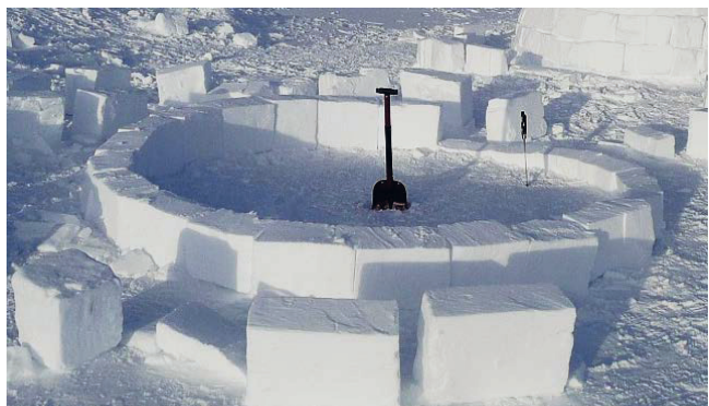
Рис. 5. Последовательность сооружения иглу
